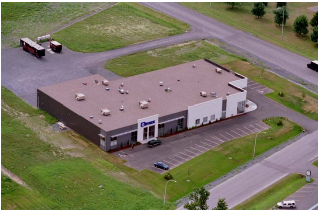
Figure 3 Photo aérienne de l'immeuble situé au 4555 rue Beaudry, Saint-Hyacinthe, août 2000
